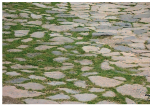
Réaliser des surlargeurs pavées
