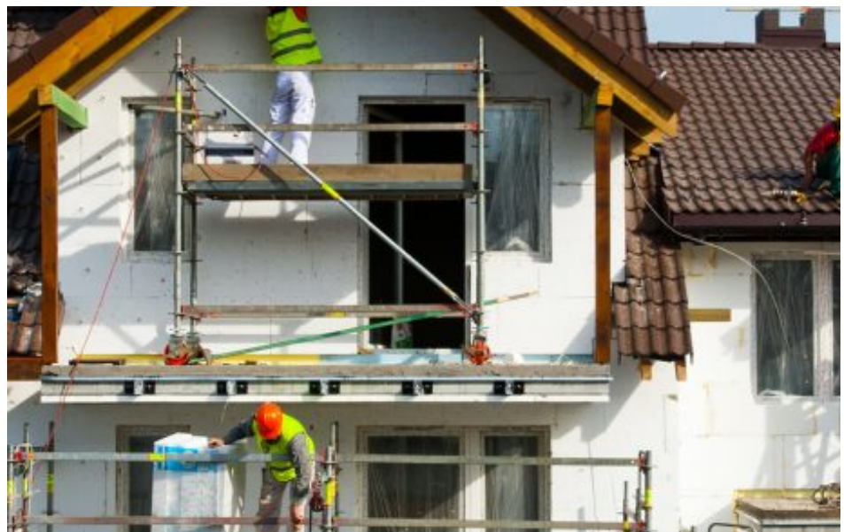
ISOLATION DES MURS PAR L'EXTÉRIEUR
