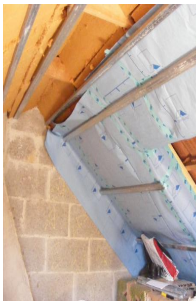
ISOLATION DES COMBLES
